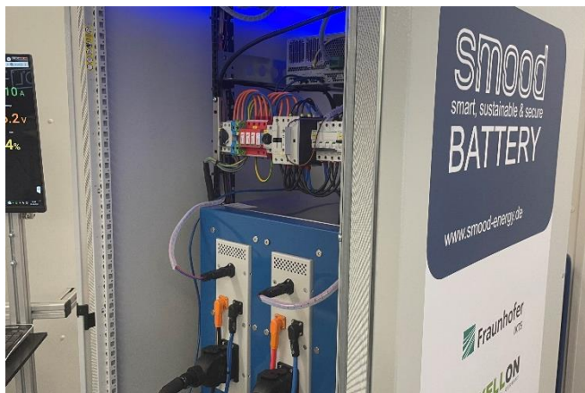
Abb. 2 Die im Verbundprojekt EStorage mit dem Fraunhofer IKTS entwickelte Natrium-Nickelchlorid-Batterie wird eine nachhaltige, sichere und günstige Lösung zur Stromspeicherung liefern.
